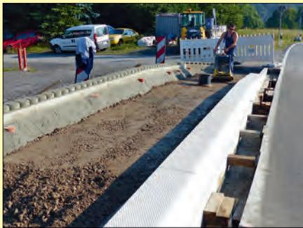
Das Betonbett, in dem die Palisaden stehen, wird in regelmäßigen Abständen in Vertiefungen auf. Hier hinein kamen Hülsen zum Befestigen eines Geländers. Es soll verhindern, dass Personen versehentlich über die Palisaden stürzen.
