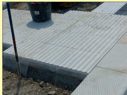
Die Oberfläche ist strukturiert, um einen sicheren Tritt bzw. Stand bei widrigen Witterungsbedingungen zu gewährleisten. Die Fläche zwischen dieser Reihe und der angrenzenden Rasenkante wird später asphaltiert werden. Unterhalb des Überganges zur landwirtschaftlichen Nutzfläche entstand noch ein Stück Fußweg.
