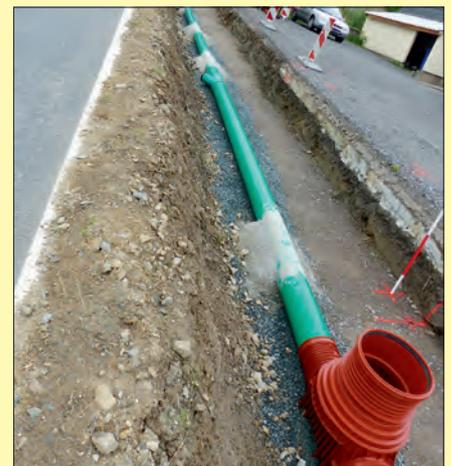
Die Entwässerungsrohre wurden in regelmäßigen Abständen durch ein Betonbett fixiert. Zwei Schächte sollen zusätzliches Oberflächenwasser auffangen und weiterleiten.
