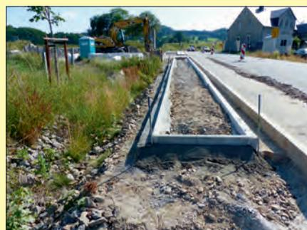
Sämtliche Borde im neuen Haltestellenbereich sind inzwischen gesetzt. Auch der geplante Fußweg ist rückseitig mit Borden eingegrenzt wurden. Die Zwischenräume erhalten Frostschutzmaterial als Untergrund für den Asphalt.
