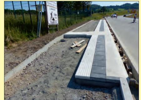
Nun konnten die Arbeiten an der gegenüberliegenden Haltestelle beginnen. Hier wurde der Aufwand größer, weil die Entwässerungsmulde verschwinden musste, dafür wurden in diesem Bereich unterirdische Entwässerungsrohre gelegt. Der gesamte Bereich ist 26 m lang und grenzt unmittelbar an das Grundstück vom Autohof Lange.
