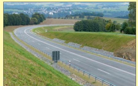
Während der Bauzeit zogen mehrmals heftige Unwetter über die Region. Zerstörungen auf der Baustelle zeugten vor allem von der Kraft des Wassers. Vielfach mussten weggespülte Böschungen noch einmal profiliert werden. Auch Entwässerungsmulden mit Steinschüttungen suchte man nach dem Regen teilweise vergebens. In Auswertung der
