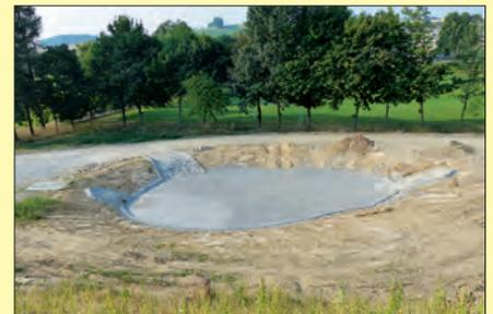
Ein hartes Stück Arbeit steckt in der Gestaltung der Entwässerungsmulden, die als Raubett geformt werden mussten. Zusätzliche Überläufe von höher gelegenen Flächen in die darunter liegenden Mulden sollen das Schadensrisiko bei Unwettern minimieren. Besonders gefährdete Schachteinläufe wurden zunächst gegen eine recht offene Gitterhaube ausgetauscht. Da die Böschungen und Mulden noch nicht richtig bewachsen sind, wird bei Starkregen immer wieder Schlamm und Pflanzenreste mitgeführt. Dieses
