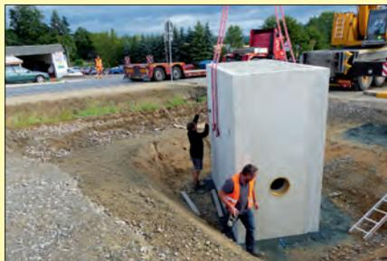
Nun wurden die beiden Behälter an die Streckenentwässerung angeschlossen.
