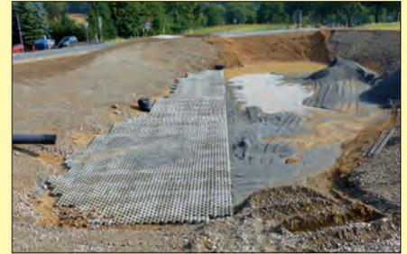
Dafür ist nun das Rückhaltebecken 1 beim Bauwerk 1 fertig. Die Entwässerungsmulde wurde bis zum Bachdurchlass verlängert. Vom letzten Schacht, dessen Ablauf in das Rückhaltebecken läuft, erhielt die Mulde Steinschüttung.
