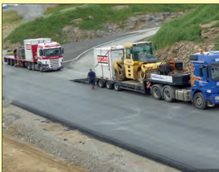
Ausgehend vom Chausseehaus entstanden ab dem 29. Juni die Bankette. Der Bankettfertiger brachte das Material auf den vorgesehenen Streifen, ein Radlader mit einer Drängelrüttelplatte verdichtete das Ganze.
