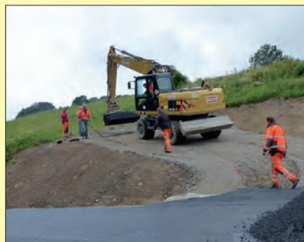
In Vorbereitung der letzten Asphalt-schicht für die gesamte Trasse wurde der obere Bereich mit Hochdruck gereinigt. Dazu war ein Spezialfahrzeug im Einsatz. Anschließend wurde der Schmutz über eine Kehrmaschine aufgenommen.
