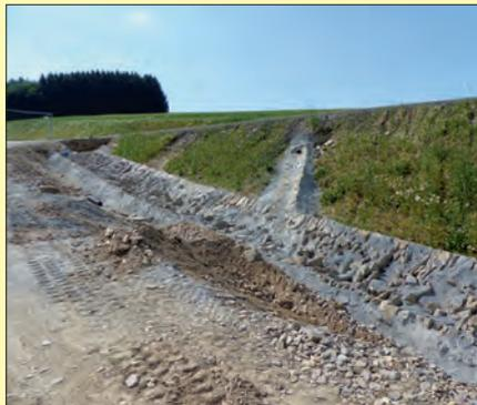
Solche Raubett-Mulden entstanden bzw. entstehen noch an mehreren Abschnitten. Ihr Bau wurde aus der Unwetter-Erfahrung der Vergangenheit notwendig. Zur Milderung evtl. Unwetterschäden sind auch neben dem Bauwerk 3 Kaskaden gebaut wurden. Sie können größere Wassermassen direkt in die darunter befindlichen Entwässerungsmulden leiten.
