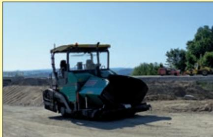
Am 08. Juni wird vom unteren Ortseingang ausgehend in Richtung Bauwerk 3 die erste Asphalterschicht (eine 10 cm starke Trageschicht) aufgezogen. Mehrere Spezialwalzen verdichten das Mischgut.
