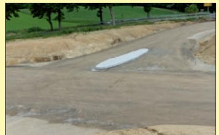
Die große Verkehrsinsel am Kreisel wird nicht gepflastert. Sie erhält eine Decke aus Asphalt. Als Untergrund wurde Frostschutz verwendet und verdichtet.
