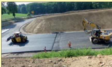
Die Binderschicht wird auf der Haupttrasse 8 cm betragen, auf der Zufahrt zum Kreisel nur 6 cm. Die verschiedenen Schichten unterscheiden sich in der Zusammensetzung. Die Trageschicht ist am Größten, die Deckschicht wird am Feins-
