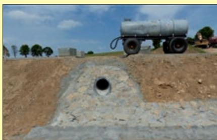
Das Rückhaltebecken 3 ist fertig. Die Böschungen erhielten Steinschüttungen. Die Schächte wurden noch an das Höhen-niveau des Geländes angepasst. Dazu
