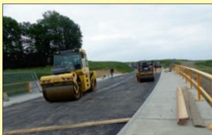
Mittlerweile wurde auf der gesamten Trasse die Trageschicht und teilweise auch schon die Binderschicht aufgetragen.
