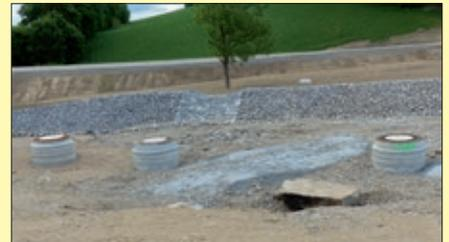
Im unteren Trassenbereich entstand die nächste Verkehrsinsel. Sie umfasst ca. 20 m<sup>2</sup> Fläche. Etwa 5 Tonnen Granitpflaster wurden zum Füllen benötigt.
