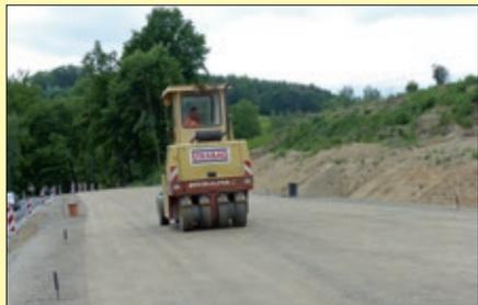
Die Trasse vor dem Chausseehaus konnte wegen der Nähe zum Wohngebäude nicht so tief ausgehoben werden. Dadurch war auch nicht der sonst notwendige Aufbau mit Frostschutz möglich. Hier wurde eine hydraulisch gebundene Tragschicht verwendet. Die seitliche Begrenzung zum Grundstück erfolgt mit Granitborden.
