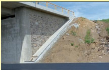
Nach wie vor sind die Entwässerungsmulden in Arbeit. Als Resultat des Unwetters vom 27. April erfolgt für mehrere große Abschnitte eine Neugestaltung. Die Steine werden in ein Betonbett gelegt. Eine sehr aufwendige und mühselige Arbeit, da jeder Stein einzeln in den Beton gearbeitet wird, um ein vernünftiges Raubbett zu erhalten. Durch die grobe Bauweise mit unterschiedlichen Steinen wird die Fließge-
