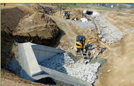
bereich des Durchlasses 5 sind die Arbeiten noch nicht abgeschlossen. Rings um die Brückenflügel der Durchlässe und an der Schutzmauer beim Hochspannungsmast gegenüber vom Sportplatz wurden Pflastersteine gelegt.
