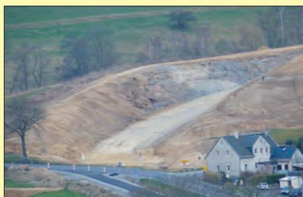
Da die Böschungen bereits profiliert werden, entsteht schon ein ziemlich fertiger Eindruck. Es ist aber natürlich noch jede Menge zu tun. Mit der Anbindung an die B 101 wird der nächste große Schritt bis zur Fertigstellung getan sein. Dann wird auch relativ schnell die Schotterpyramide als Unterbau für die Asphaltierung zusammen schrumpfen und die begonnene Beräumung des Areals wird weiter fortgesetzt werden können.
