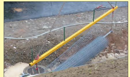
Die Telekomleitung im Bereich der Kirchenstraße wurde auch wieder zurück verlegt. Sie musste zu Beginn der Bauarbeiten für die Brücke weichen. Durch eingebaute Leerrohre wurde das neue Telekomkabel hindurch geführt. Die in dem Kabel befindlichen 800 Litzen mussten dann jeweils 20 Stückweise umgeklemmt werden. Wahnsinn!
