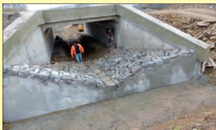
Dorfbach) weiter. Analog wie beim Bauwerk 1 wurde auch beim Bauwerk 4 das Bachbett gestaltet. Der Zulaufbereich erhielt eine zusätzliche Verstärkung, damit das Brückenfundament nicht unterspült wird. Der Auslaufbereich wird Staustufen erhalten, so dass das Erdreich nicht weg geschwemmt werden kann.
