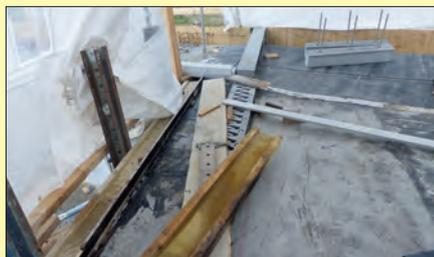
Die Betonpumpe ragte am 01. Dezember letztmalig über dem Bauwerk 3. Die Kapfen und Randstreifen neben der Fahrbahn wurden ausgegossen. Auch der Grundrohrsockel wurde befüllt.
