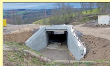
Im Bauwerk 1 erfolgte noch die Gestaltung des Bachbettes mit groben Steinen. Aber auch der Zulauf- und Ablaufbereich wurden in dieser Art angelegt. In den Ablaufbereich mündet inzwischen der Ablauf des Regenrückhaltebeckens 1.
