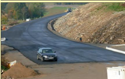
Die fertige Asphaltfläche wird regelmäßig gereinigt, damit die nachfolgende Binderschicht sich auch wirklich mit der unteren
