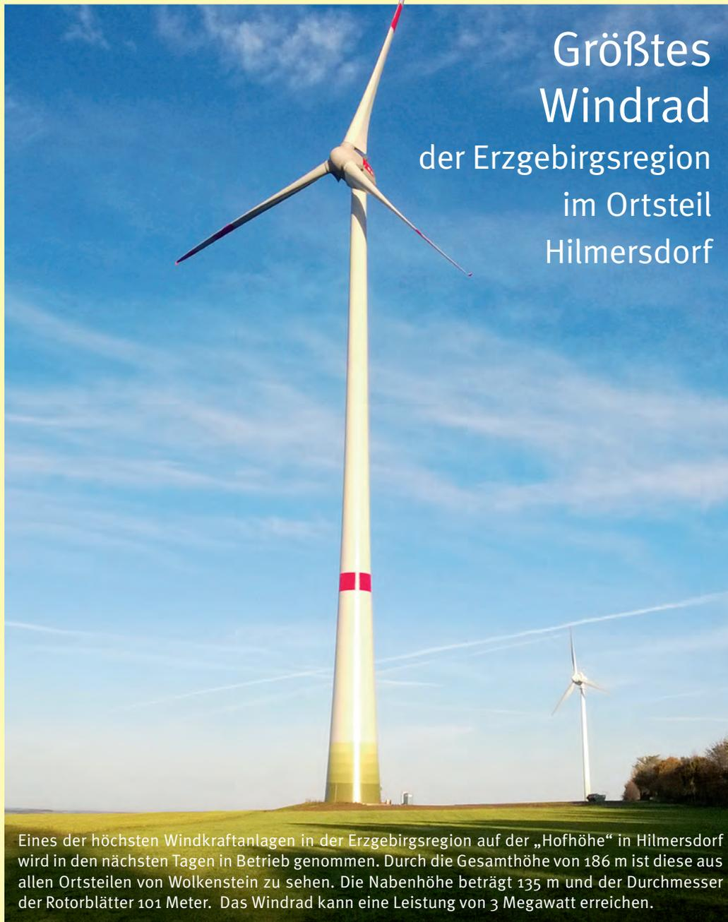
Eines der höchsten Windkraftanlagen in der Erzgebirgsregion auf der „Hofhöhe“ in Hilmersdorf wird in den nächsten Tagen in Betrieb genommen. Durch die Gesamthöhe von 186 m ist diese aus allen Ortsteilen von Wolkenstein zu sehen. Die Nabenhöhe beträgt 135 m und der Durchmesser der Rotorblätter 101 Meter. Das Windrad kann eine Leistung von 3 Megawatt erreichen.
