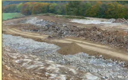
Wenn im kommenden Jahr der Anschluss an die B 101 gebaut wird, muss ja trotzdem der Verkehr weiter rollen. Deshalb wurde bereits jetzt eine provisorische Straße angelegt, die dann einspurig mittels Ampelregelung befahrbar sein wird.
