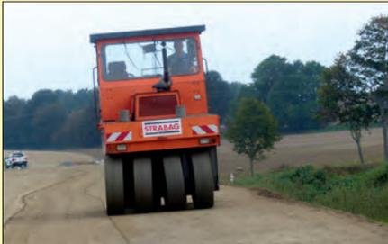
Und genau auf diesem Abschnitt wird jetzt der Asphalt, den wieder eine Chemnitzer Firma liefert, aufgetragen. Zunächst ist es ebenfalls eine 10 cm starke Tragschicht. Damit die Höhen eingehalten werden, befindet sich seitlich an der Asphaltiermaschine eine Art „überdimensionale Wasserwaage“. Mittels Ultraschall – Messungen in Richtung Fahrbahnoberfläche wird soviel Asphalt aufgetragen, dass evtl. Unebenheiten des Untergrundes ausgeglichen werden und die Oberfläche glatt wird.
