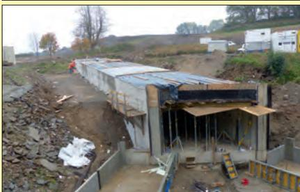
Nun werden auch hier wieder die Brückenflügel eingeschalt. Seitlich ist die Brücke bereits aufgefüllt wurden. Damit entfällt der Bau von Gerüsten. Das spart Zeit und ist auf dem festen Untergrund für die Arbeiter ein sicheres Arbeiten.
