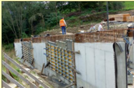
die große Brücke, aber trotzdem auch ziemlich lang. Die Bauweise erfolgt in Einzelsegmenten. Inzwischen sind die Seitenwände aller 5 Einzelteile fertig. Zuletzt wurden noch die Zwischensegmente 2 und 4 mit Beton ausgegossen. Für den nächsten Arbeitsabschnitt ist die Deckenschalung bereits angeliefert wurden.
