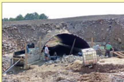
momentan die Brückenflügel und Portale. Sie werden aus Natursteinen gemauert. Hinter der Natursteinmauer entsteht noch eine ca. 50 cm starke Schicht aus Beton, um dem Druck durch das aufzufüllende Erdreich standzuhalten.
