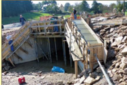
Tragegerüste zu heben. Für den Überbau hat eine Leipziger Firma eine spezielle Schalung gebaut. Vorgefertigte Elemente dafür wurden angeliefert. Mittlerweile ist der Aufbau der Konstruktion fast abgeschlossen. Auch hier können wir uns das Ganze aus der Luft betrachten.
