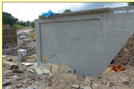
13:00 Uhr fing es an zu regnen. Obwohl der Regen teilweise sehr kräftig war, musste weiter betoniert werden. Sogar die Mittagspause fiel aus. Alle Arbeiter wurden zum Einfüllen des Betons gebraucht. Als Mittagessen gab es „kaltes Buffet“ direkt auf der Baustelle. Mittlerweile wird auch das untere Widerlager eingeschalt, während das obere Widerlager weitestgehend ausgeschalt wurde. Die Außenseiten sind mit Verwahrungen versehen. Diese werden später noch mit Natursteinen ausgefüllt.
