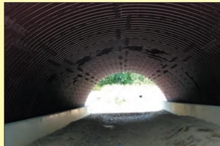
Eine Seite hat schon teilweise eine Schutzschicht aus Sand und feinem Schotter bekommen. Bei der anderen Seite muss der Beton noch abbinden. Dann erhält das
