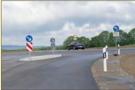
Bevor der Verkehr auf dem Abschnitt von der Schachtstraße bis zu den Grundstücken 16D und 16E rollen konnte, mussten noch einige Arbeiten erledigt werden. Neben der bereits asphaltierten Straße in diesem Bereich wurden mittels eines Bankettfertigers Bankette eingebaut.
