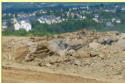
Etwa 250 Bohrlöcher wurden mit fast zwei Tonnen Sprengstoff gefüllt. Die Bohrtiefe lag diesmal zwischen 3,00 m und 6,20 m. Da das Gestein stellenweise nicht so hart war, ist es ziemlich zerkleinert worden. Damit ist zunächst die erste Schicht im Kreisel herausgesprengt worden. Die eigentliche Fahrbahntiefe wird aber noch ca. 4 m tiefer liegen. Ein riesiges Loch,
