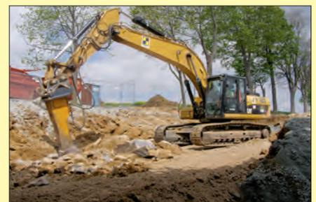
ter der Brücke verbreitert. Eine 10-kV-Leitung, die Schönbrunn mit Strom versorgt, musste tiefer gelegt werden. Da keine Sprengung möglich war, kam der große Bohrer zum Einsatz.
