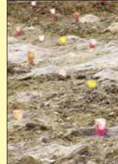
kein Gestein wieder in das Loch zurück rutschen kann. In diese Löcher kommt dann der Sprengstoff und der Trichter wird entfernt. Sind alle Löcher mit Sprengstoff gefüllt, wird alles verkabelt.
