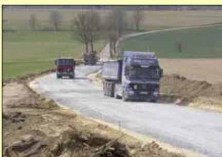
konnte. Dieses wurde auf die Fahrbahn aufgebracht und verdichtet. Gleichzeitig erfolgte auch hier die Verlegung von Drainerohren zur Streckenentwässerung. Die alte Straße ist inzwischen vollständig entfernt wurden.
