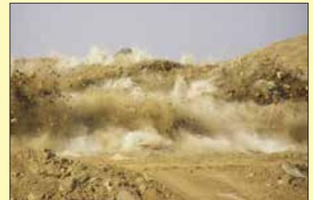
reicht. Je nach Gesteinsart benötigt man ca. 350g Sprengstoff für 1 m<sup>3</sup> Sprengmaterial. Die erste Sprengung erfolgte am 28. März gegen 13.00 Uhr. Inzwischen ist schon mehrfach gesprengt wurden.
