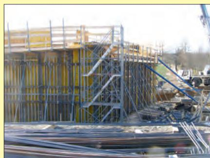
Die Einschaltung des zweiten Widerlagers geht mit großen Schritten voran. An einer Seite ist bereits die Schalung geschlossen.
