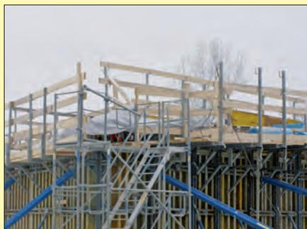
Am 29. Januar 2014 ist es soweit. Der Beton wird eingefüllt. Es werden ca. 260 m<sup>3</sup> benötigt. Da ein Betonmischfahrzeug ca. 7,5 m<sup>3</sup> bringt, wird an diesem Tag die Baustelle 35mal angefahren. Zusätzliche Arbeitskräfte sorgen dafür, dass der Beton überall gleichmäßig verteilt und verfestigt wird. Bei einer Dichte von 2,5 Tonnen pro m<sup>3</sup> muss immerhin eine Masse von 650 Tonnen Beton bewegt werden. Der Beton wird aus Gornau angeliefert.
