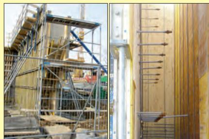
Am nächsten Tag ist die Schalung des zweiten Widerlagers bis auf die Verbindung an einem Ende fertig. Auch hier werden die Rödelsstäbe angebracht. Die Bewehrung wird bereit gelegt. Das erste Widerlager ist fast ausgeschalt. Einige Styropor-Matrizen sind bereits entfernt wurden, so dass das Mauerwerksmuster zu sehen ist.
