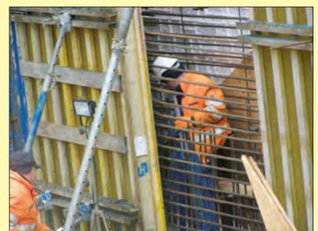
Die Schalung wird mit großen Planen abgedeckt. Im Innenraum laufen Heizgebläse. Sie sorgen für Frostfreiheit, damit der Beton eingefüllt werden kann.
