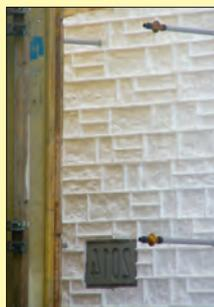
Die Schalung wurde auch an der anderen Seite geschlossen. Jetzt ist der Zugang ins Innere nur über das fehlende Schalelement am linken Brückenflügel möglich. An vorher berechneten Stellen werden Scheinfugen aufgebracht. Sie erzeugen beim Abbinden des Betons an vorge-
