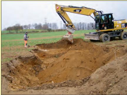
Es wurden neue Gräben gezogen, die an dem geplanten Brückenfundament vorbeilaufen. Innerhalb des abgesteckten Geländes für die Fundamente begannen zeitgleich die Ausschachtungsarbeiten.
