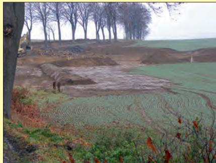
Inzwischen wird die Baugrube für die Brückenfundamente weiter ausgebaut. Auf Grund des abfälligen Geländes wird diese an der höchsten Stelle ca. 5 m und an der untersten Stelle ca. 2,50 m tief sein.
